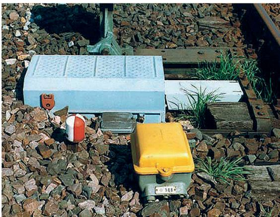
Abb. 2-47: Weichenantrieb der Firma Siemens
