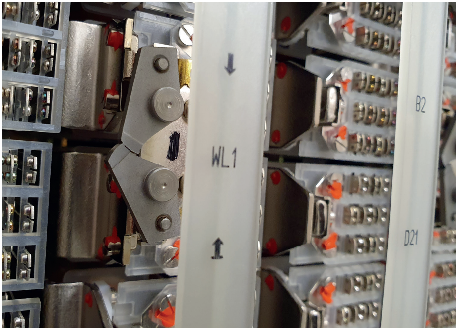
Abb. 17-6: Ankerstellung einer Weiche in einem EI L90- Stellwerk Foto: Heiko Kirsche
